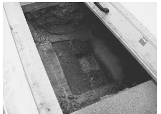
▲ Sondiergrube mit Blick auf den Sandsteinbogen (im kleinen quadratischen Ausschnitt in der Grubenmitte); darüber liegt eine Abdichtung aus Bitumen, darüber eine Sand-/Kiesschicht-Auffüllung, darüber der Asphalt des Trottoirs.
